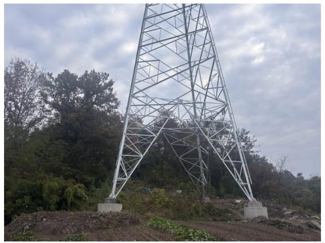
G25 塔基处旱地恢复情况
