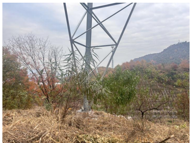
G26 塔基处桃园恢复情况
