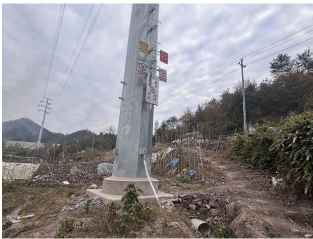
G23 塔基处旱地恢复情况
