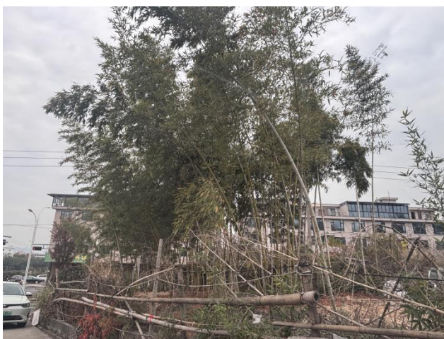
G22 塔基处恢复情况
