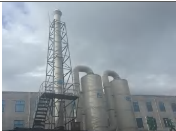
污水站废气处理设施、排气筒
