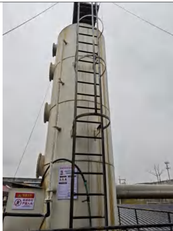
织造废气设施、排气筒 DA001
