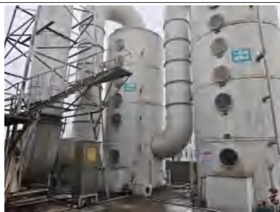
污水站废气处理设施、排气筒
