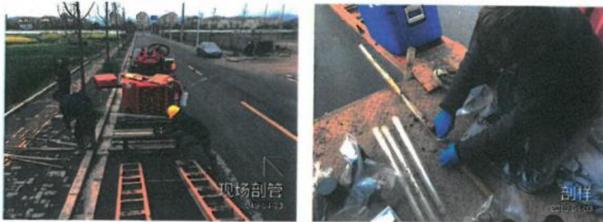
图 3 部分土壤现场剖管、取样照片
