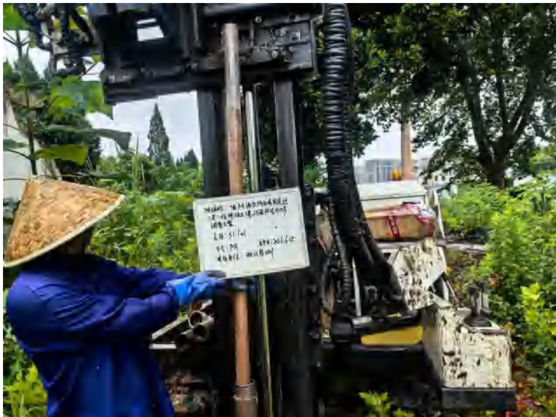
图 5-3 土壤采样钻探现场照片
