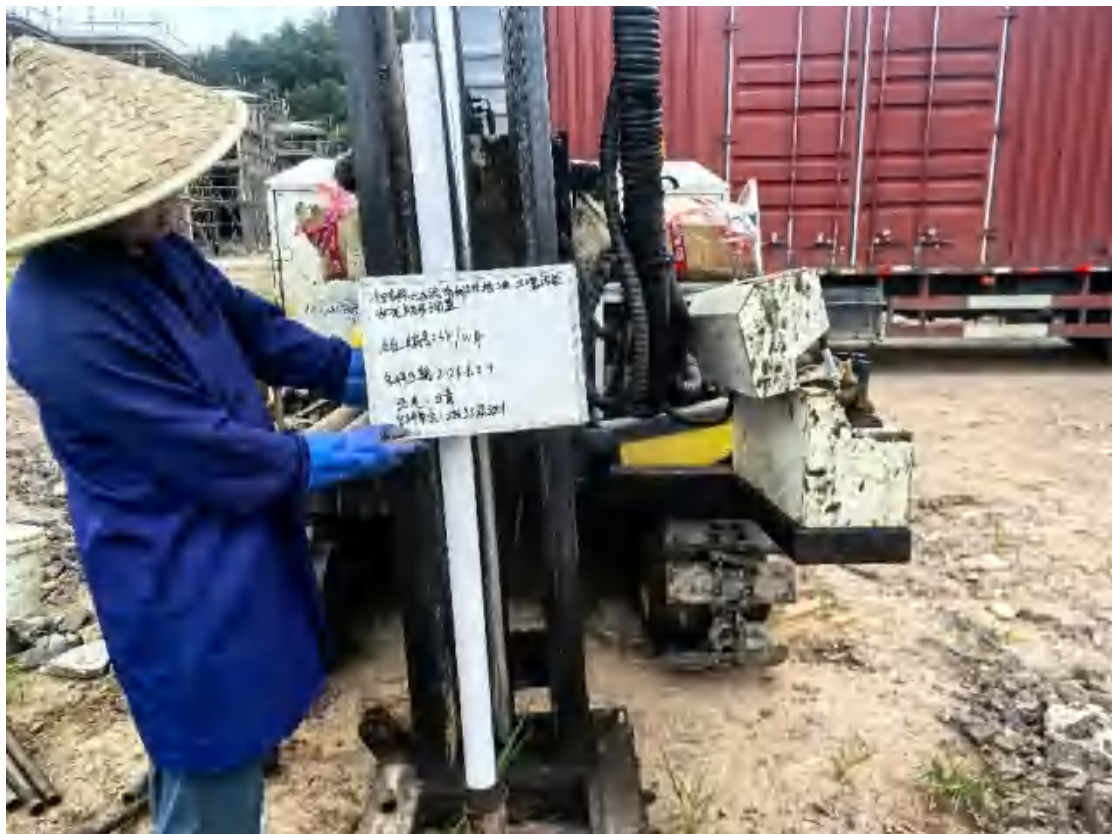
图 5-3 土壤采样钻探现场照片
