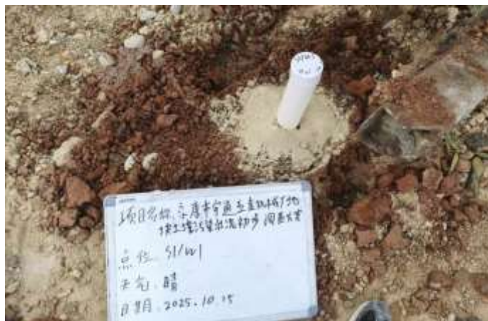
图 5.1-2 现场成井照片
