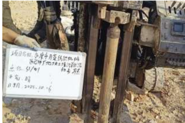
图 5.1-3 土壤采样钻探现场照片
