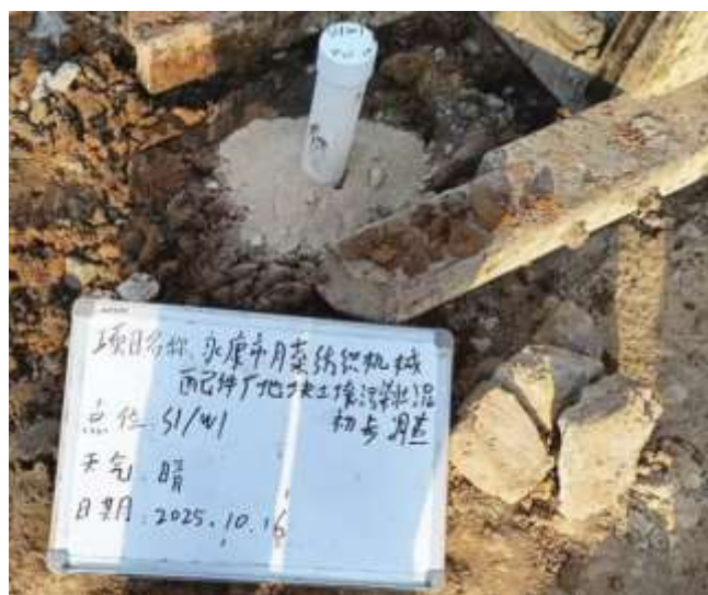
图 5.1-2 现场成井照片
