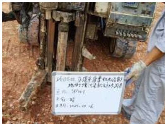
图 5-3 土壤采样钻探现场照片
