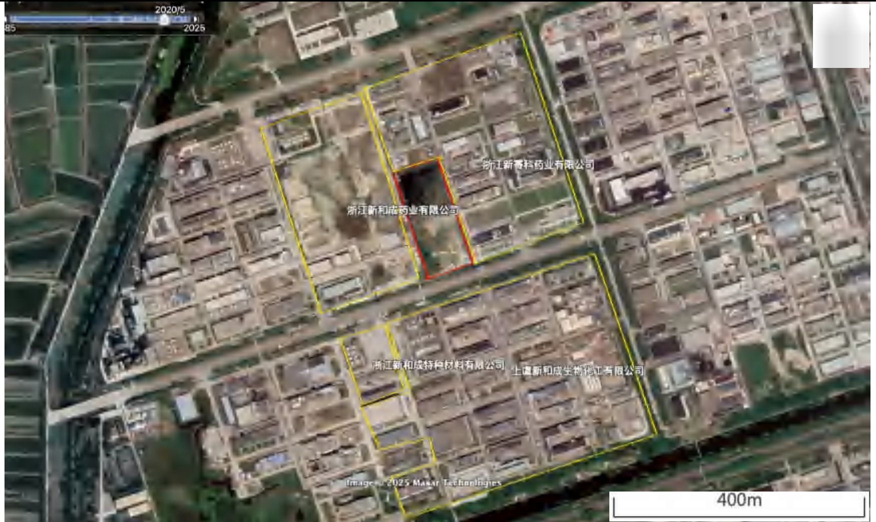
东侧为新赛科、南侧为新和成生物、西侧为新和成药业、北侧为新赛科
