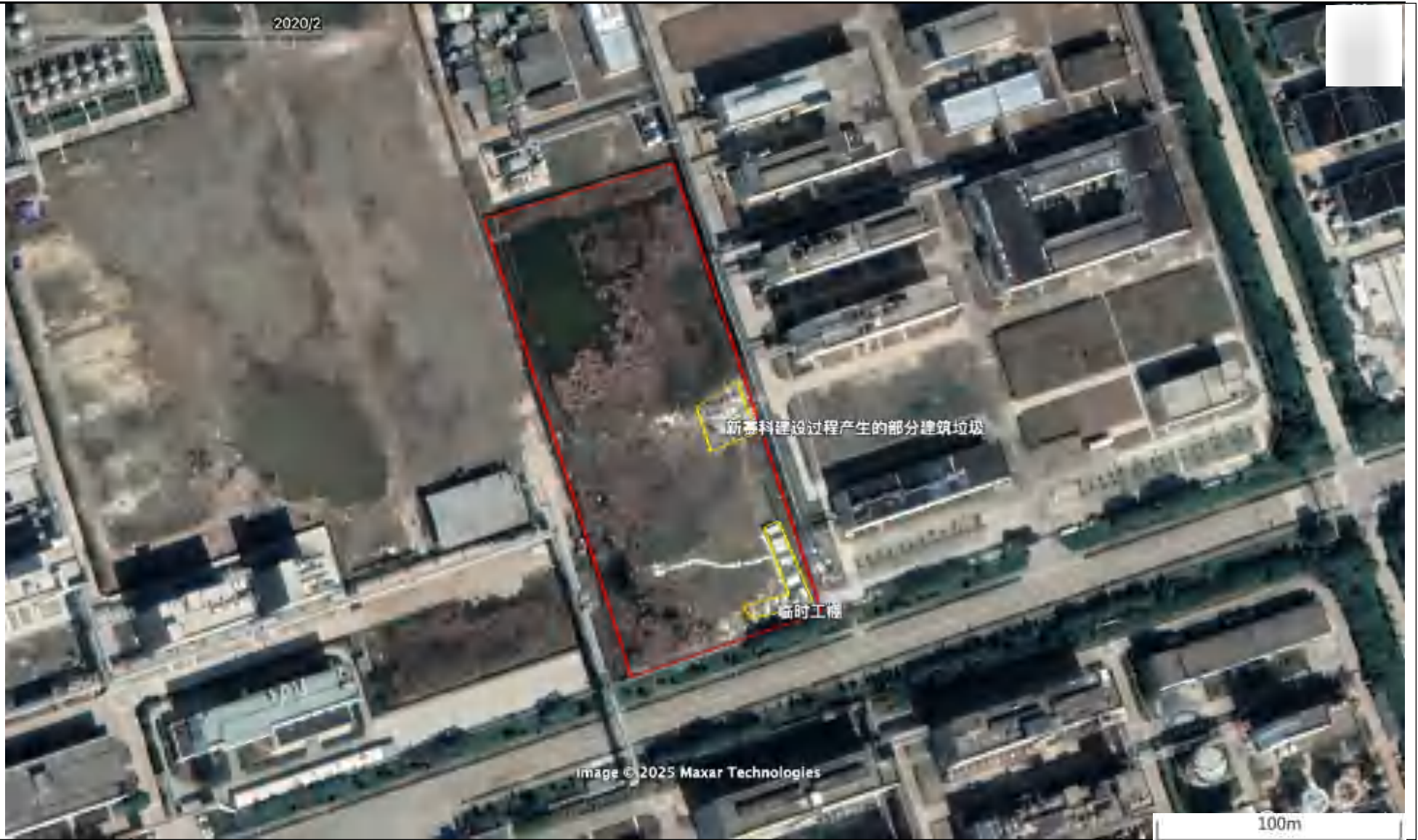
荒地、临时工棚（有部分新赛科建设产生的建筑垃圾）
