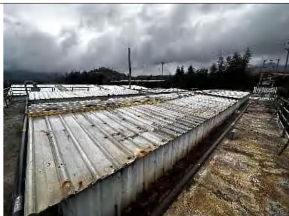
废水处理设施加盖
