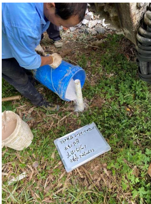
图 5-2 现场建井照片
