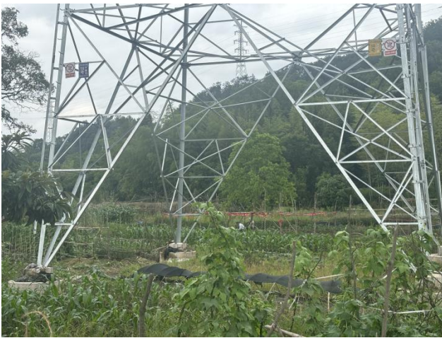
B7 塔基处耕地恢复情况
