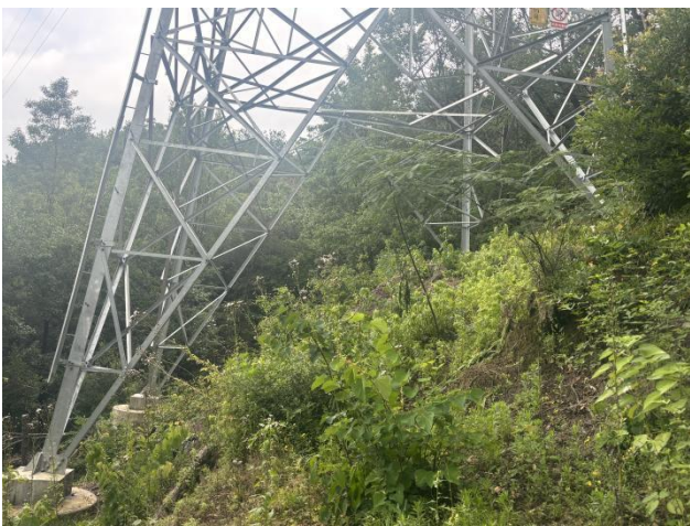
B8 塔基处山地恢复情况
