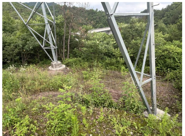
B18 塔基处山地恢复情况
