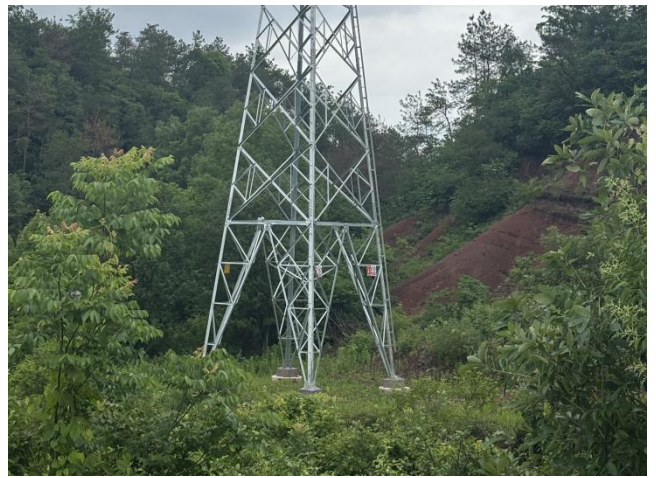
AG2 塔基处旱地恢复情况
