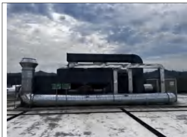
TA001 注塑、全检线、模具清洗废气“活性炭吸附脱附+催化燃烧”设施 1
