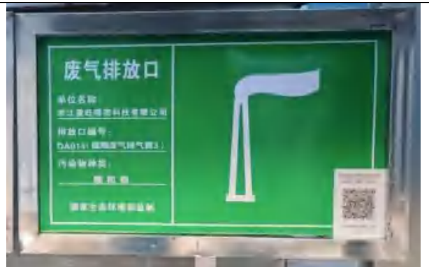
DA014 排放口标识标牌
