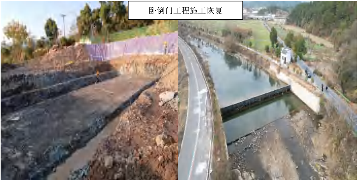
卧倒门工程施工恢复
