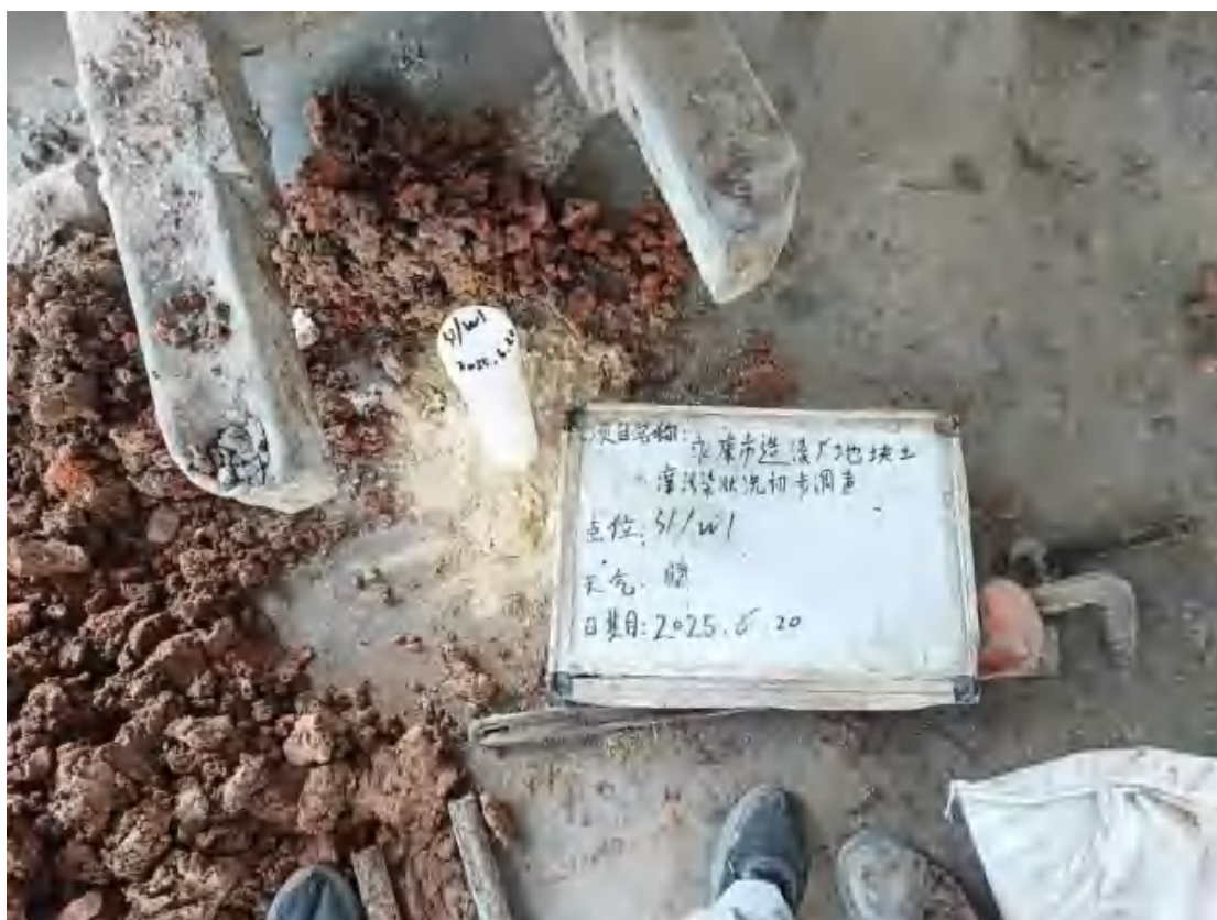
图 5-2 现场成井照片
