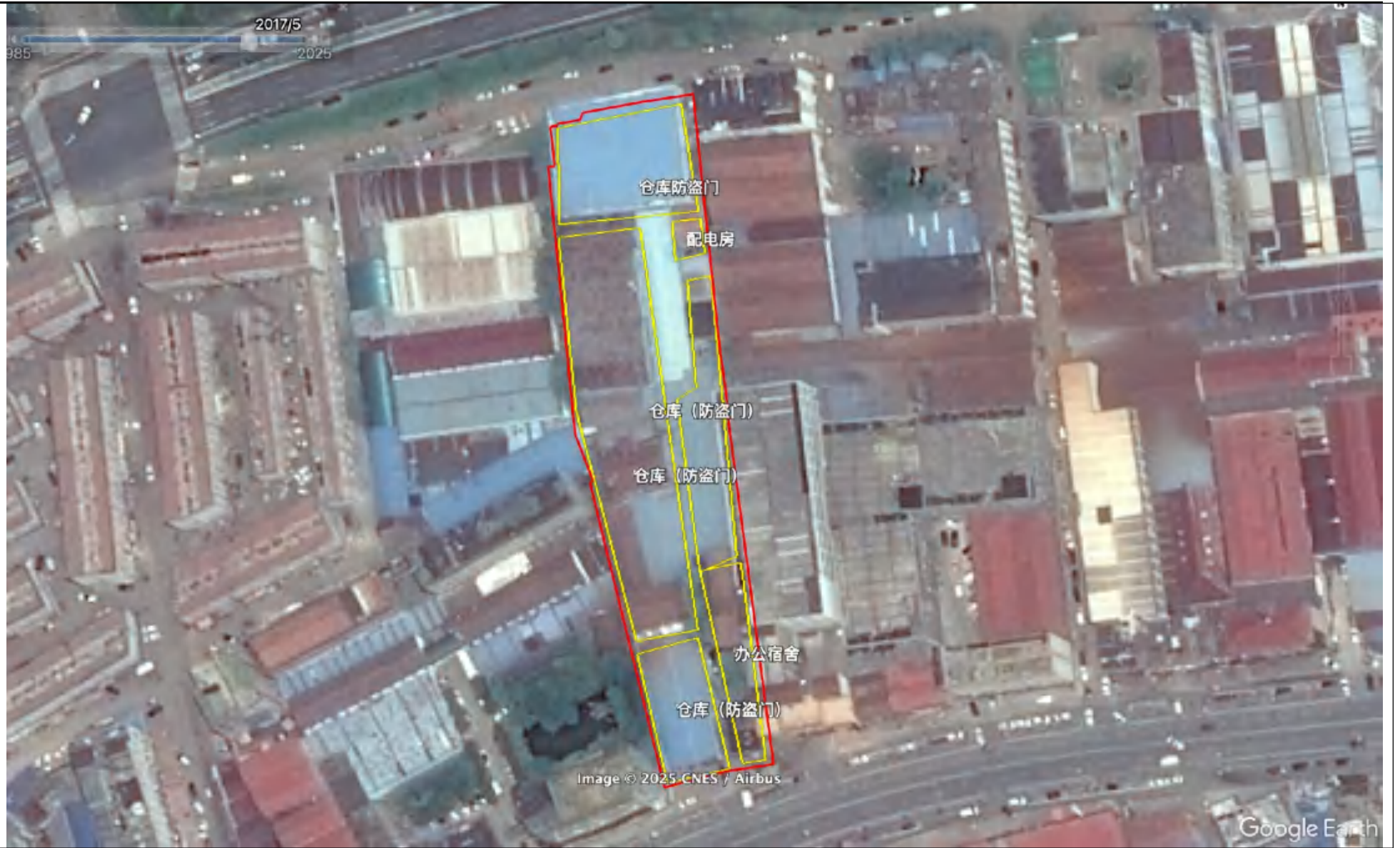
仓库（主要为防盗门）、办公宿舍楼
