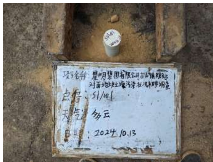
图 5-2 现场成井照片
