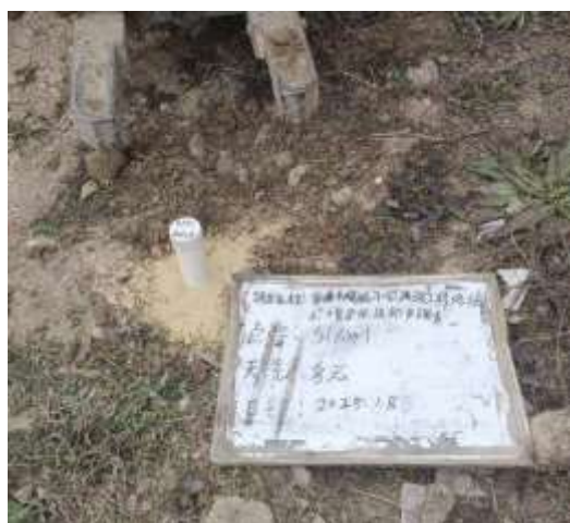
图 5.1-2 现场成井照片
