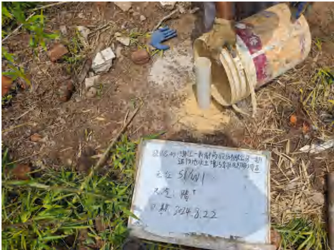
图 5-2 现场成井照片
