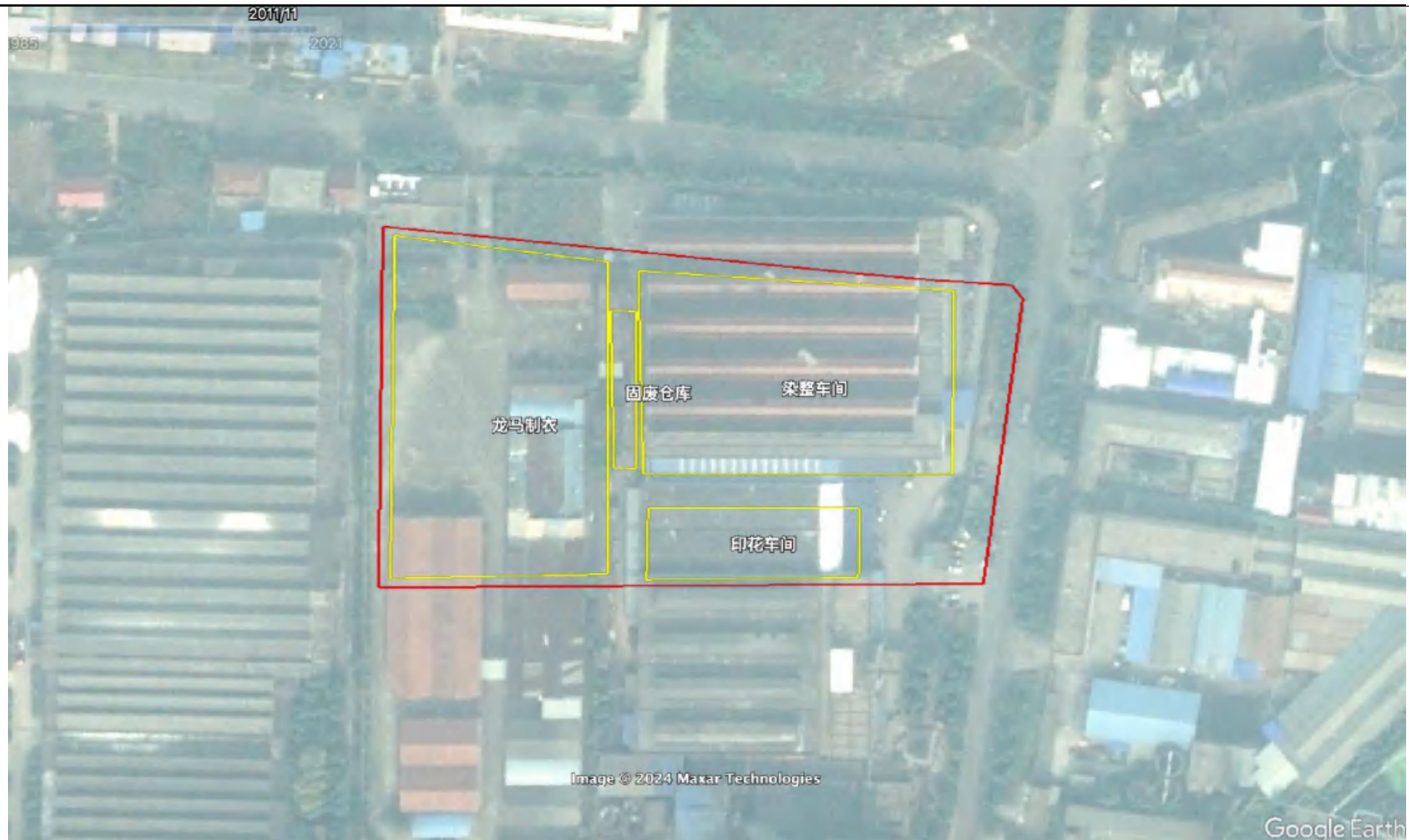
东侧为浙江云山纺织印染有限公司、西侧为浙江龙马制衣有限公司
