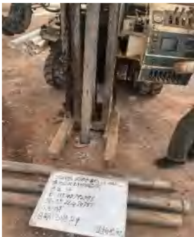
图 5-3 土壤采样钻探现场照片
