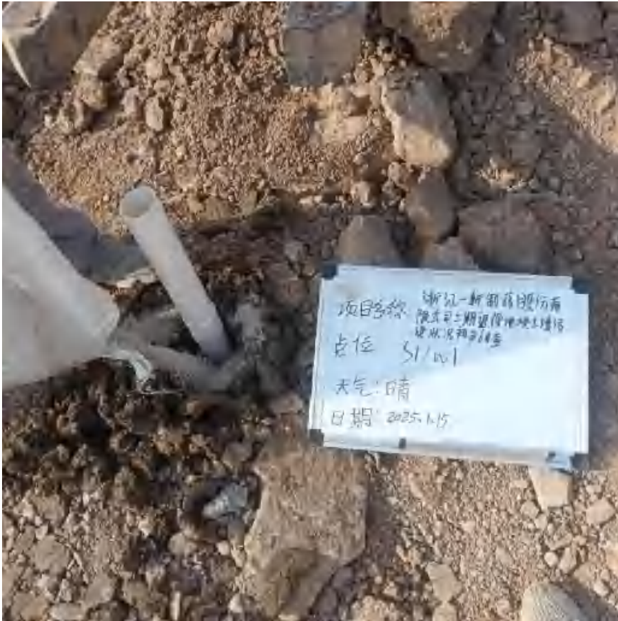
图 5-2 现场成井照片
