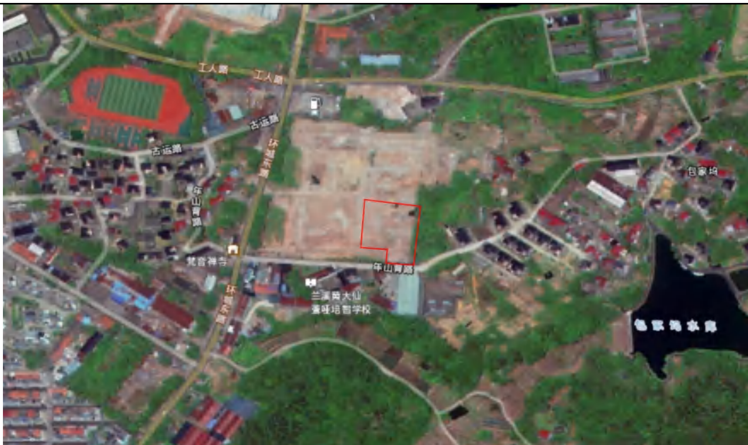
场地内已拆除
