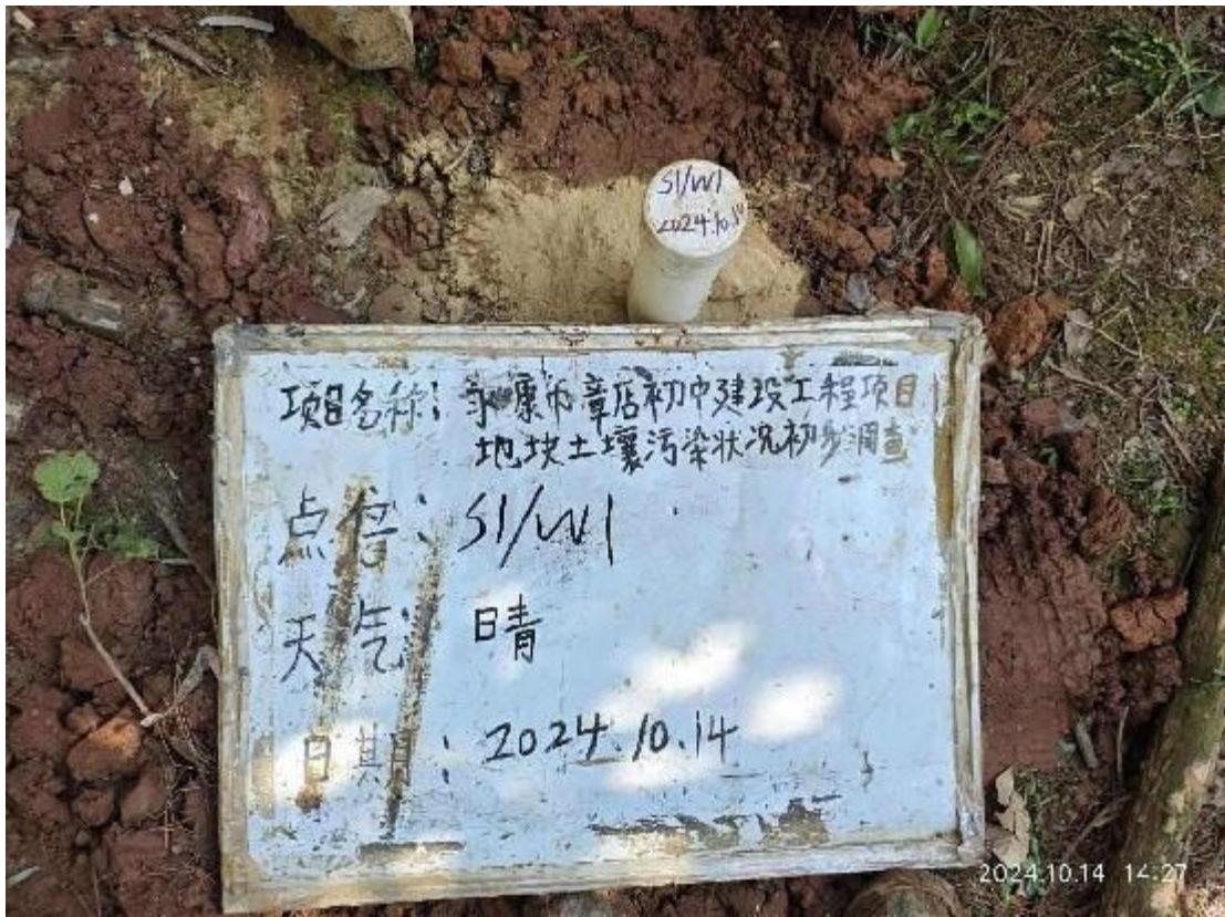
图 5-2 现场成井照片
