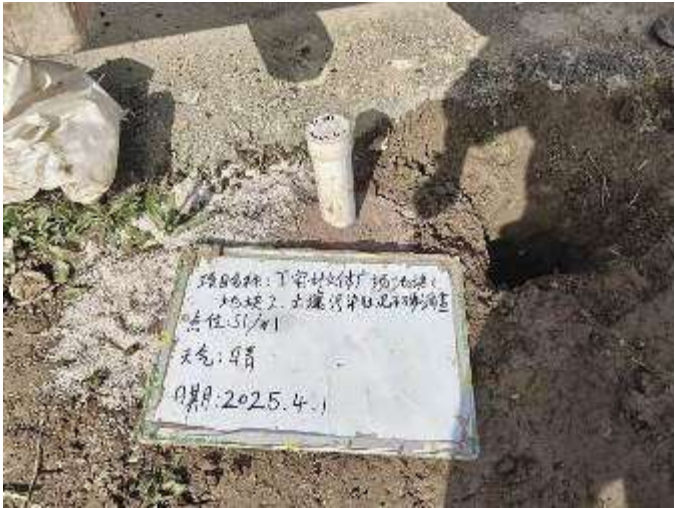
图 5.1-2 现场成井照片
