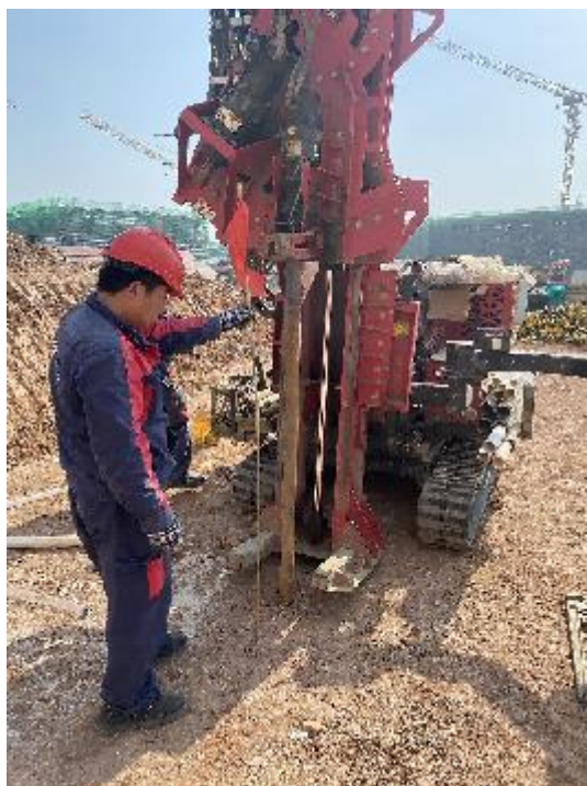
图 5-3 土壤采样钻探现场照片
