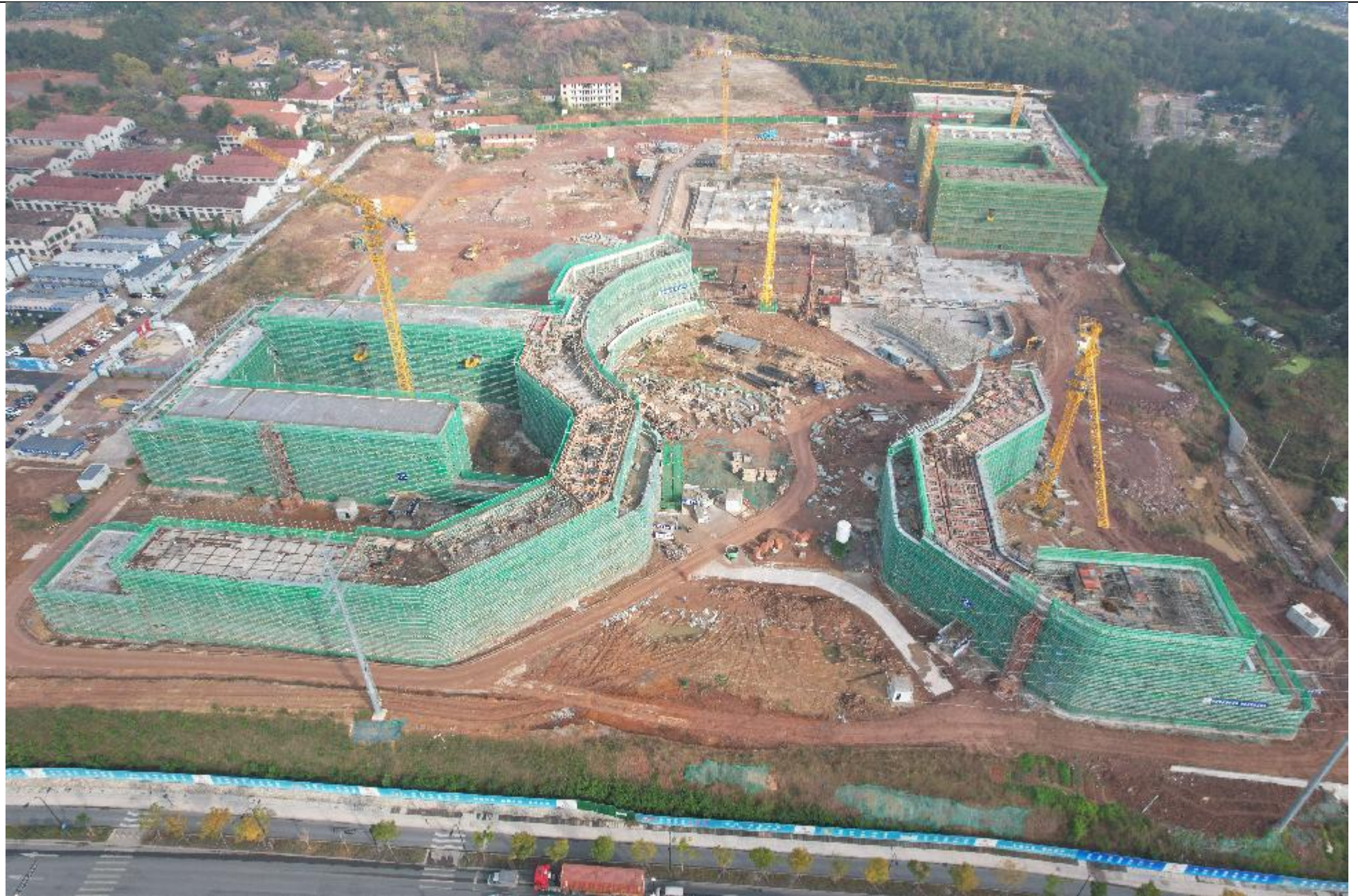
图 3-7 地块内现状航拍图
