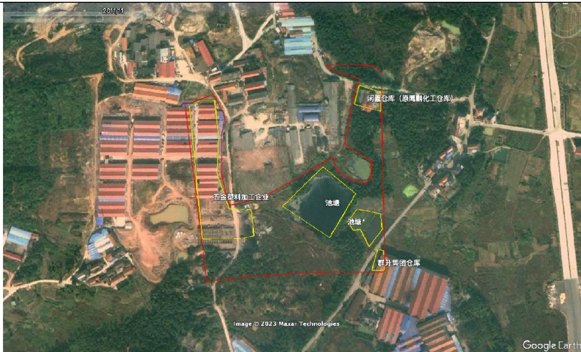
五金、塑料加工小作坊集聚区、池塘、群升集团仓库和闲置仓库（原堆放萤石矿）
