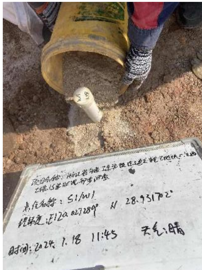
图 5-2 现场成井照片
