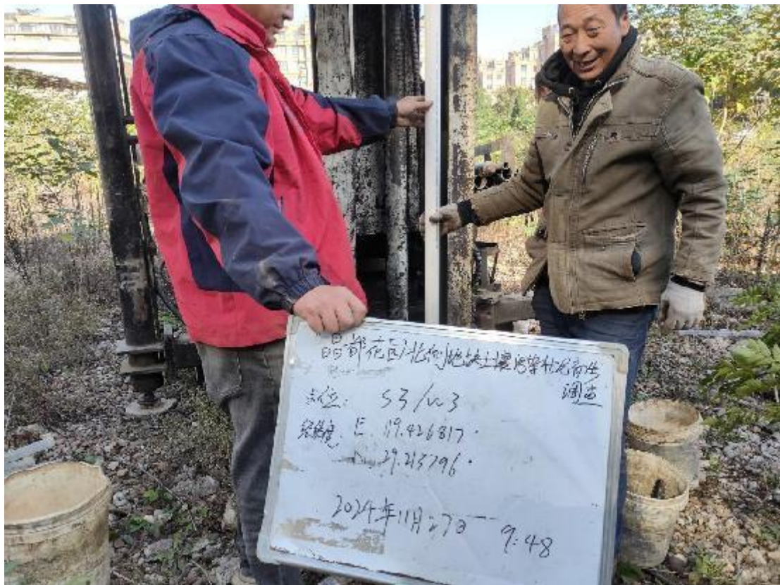
图 5-2 现场建井照片
