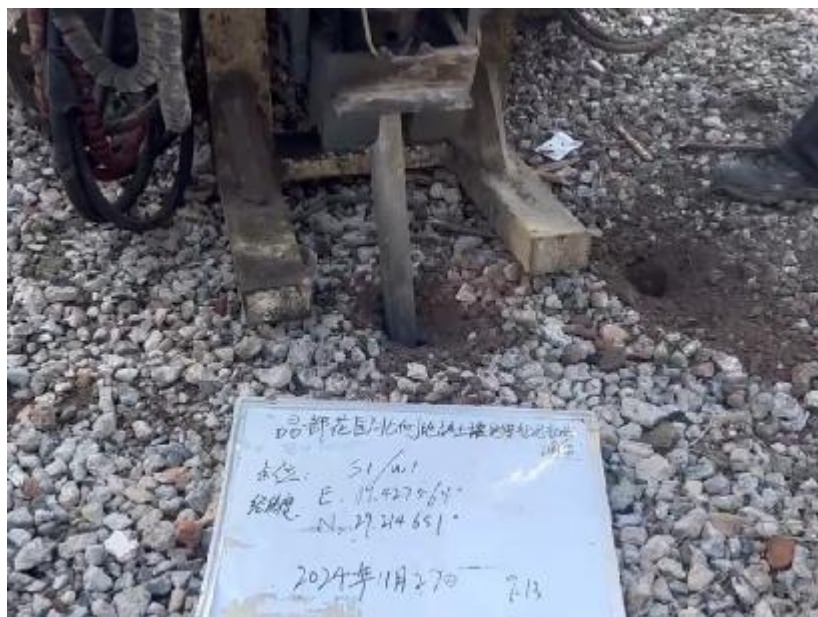
图 5-7 实际挪点钻探照片
