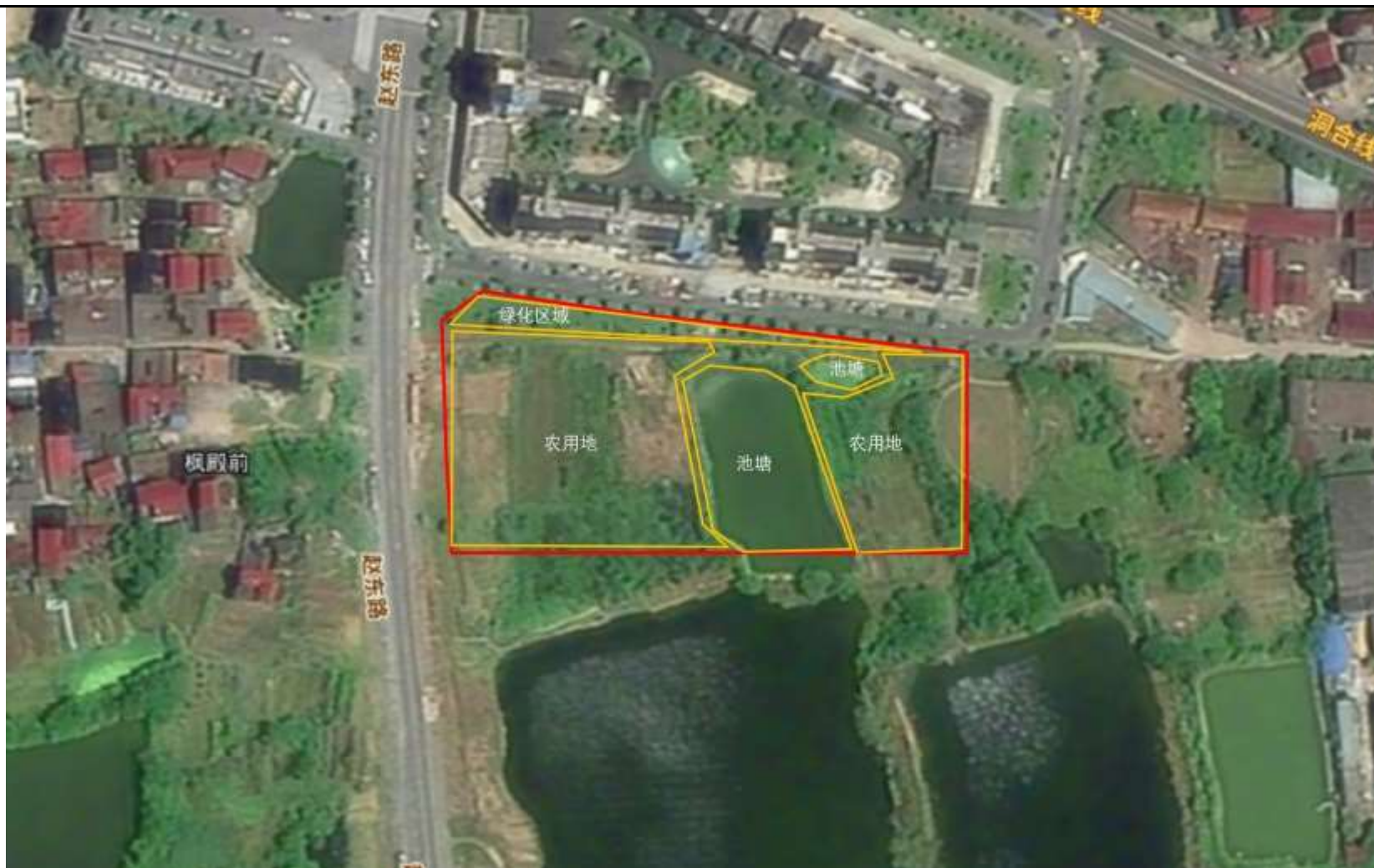
农用地、池塘（北侧池塘面积缩小，填土来源于附近农田土壤）、绿化区域
