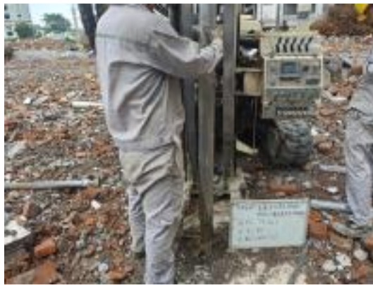
图 5-3 土壤采样钻探现场照片
