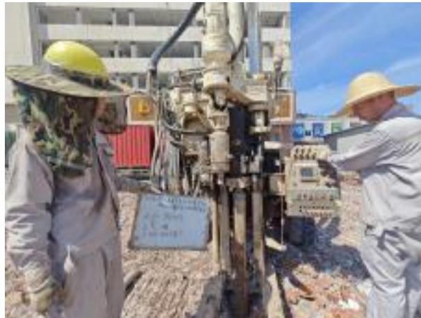
图 5-3 土壤采样钻探现场照片
