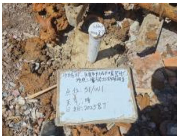
图 5-2 现场成井照片
