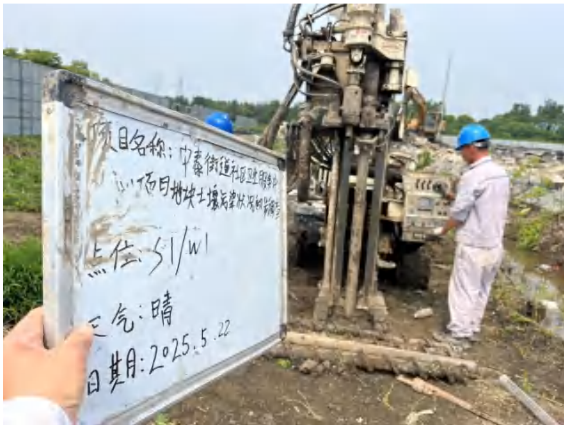
图 5-3 土壤采样钻探现场照片
