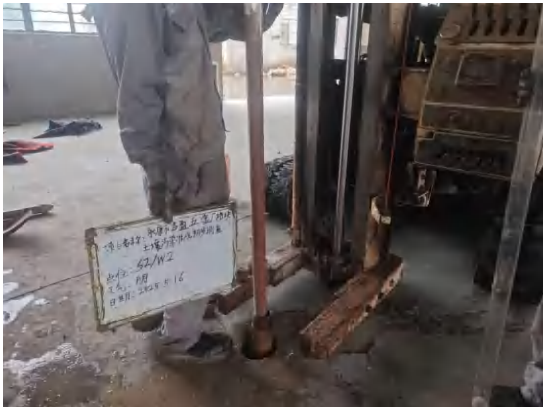
图 5-3 土壤采样钻探现场照片
