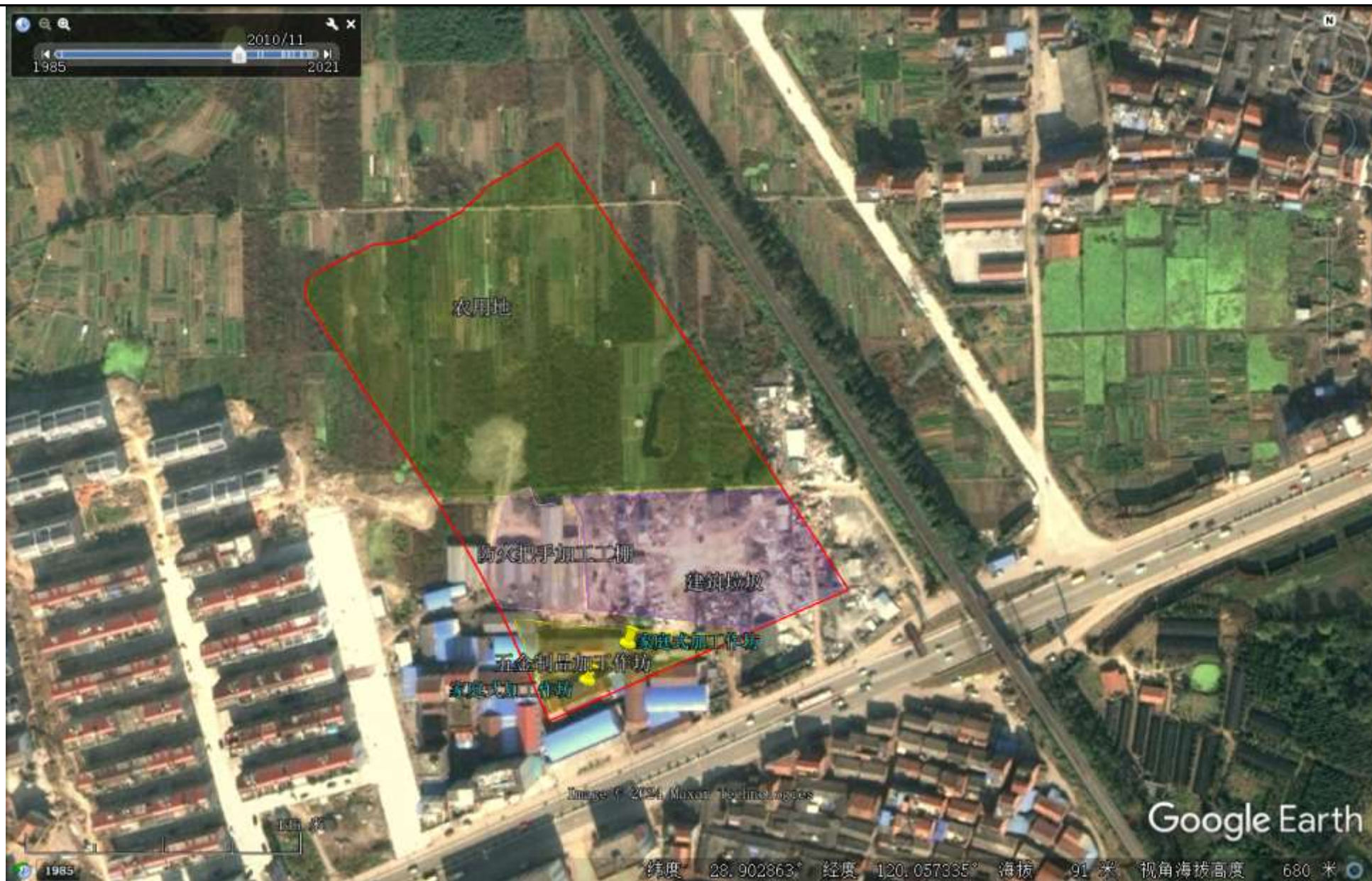
东侧为防火把手加工工棚，西侧为建筑垃圾堆放，北侧为农用地，南侧为五金制品加工工作坊（为家庭式加工工作坊）
