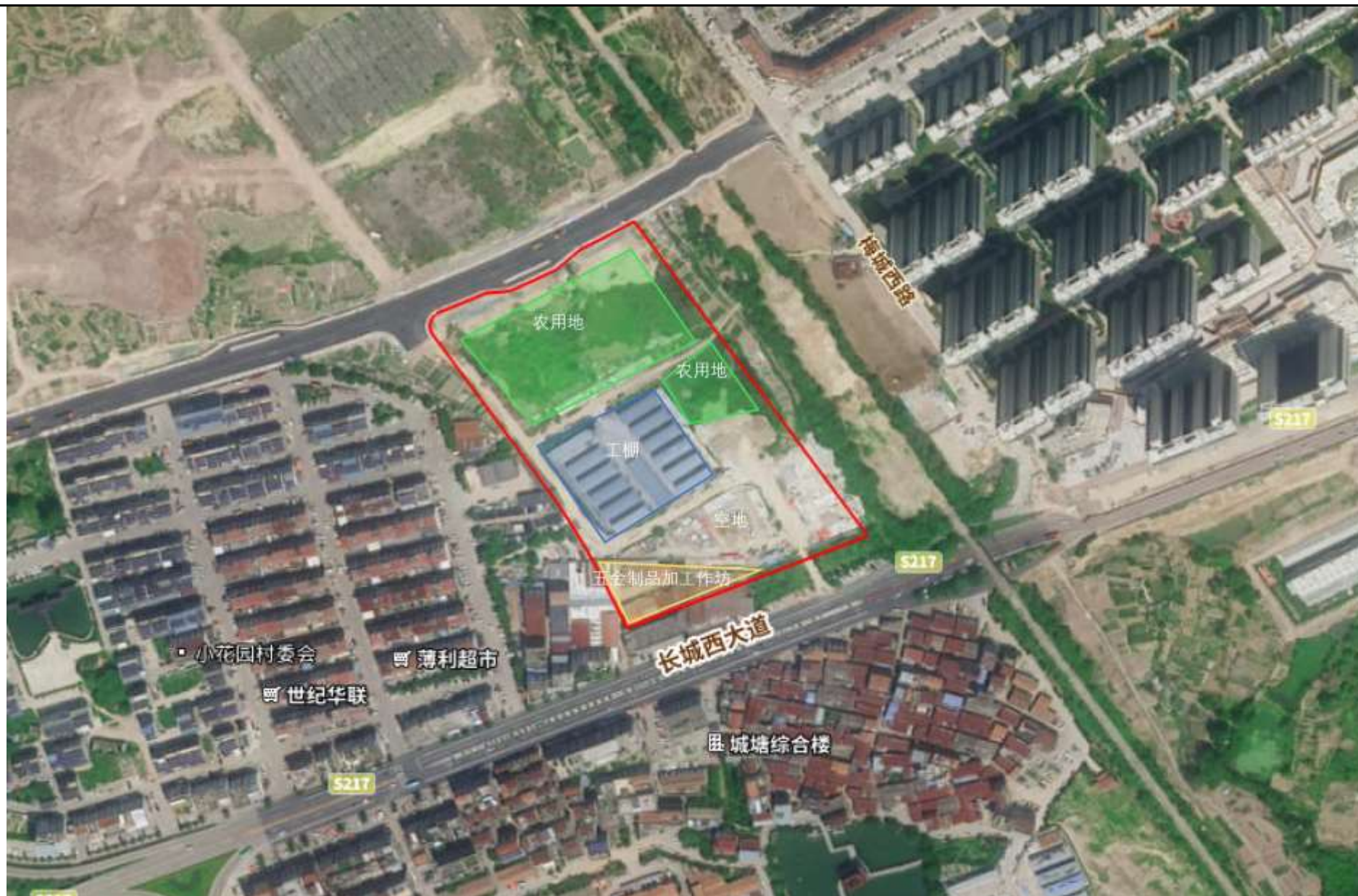
北侧为农用地，东侧为农用地，西侧为临时工棚，南侧为五金制品加工作坊（为金邦标准件厂和家庭式加工作坊）、空地
