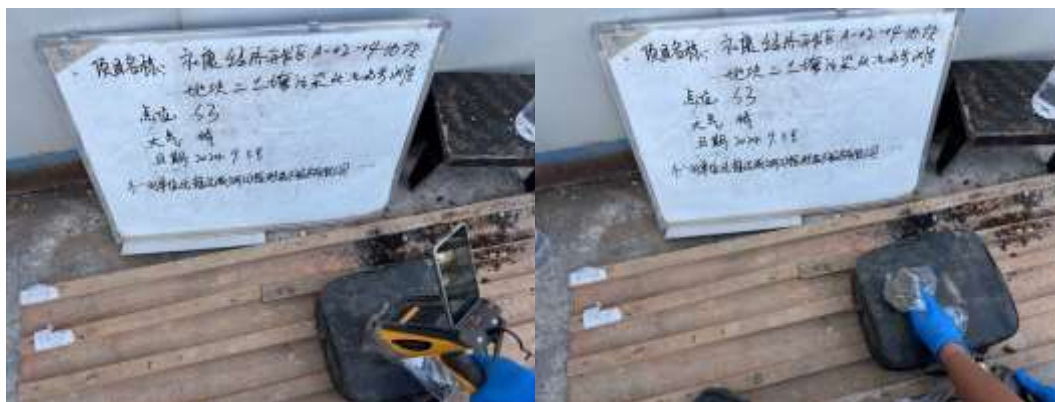
图 5-4 现场快速检测照片
