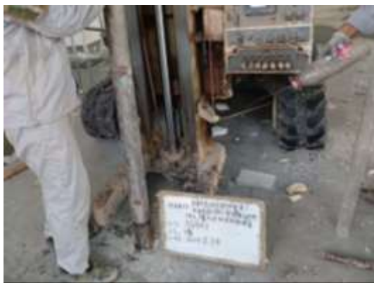
图 5-3 土壤采样钻探现场照片
