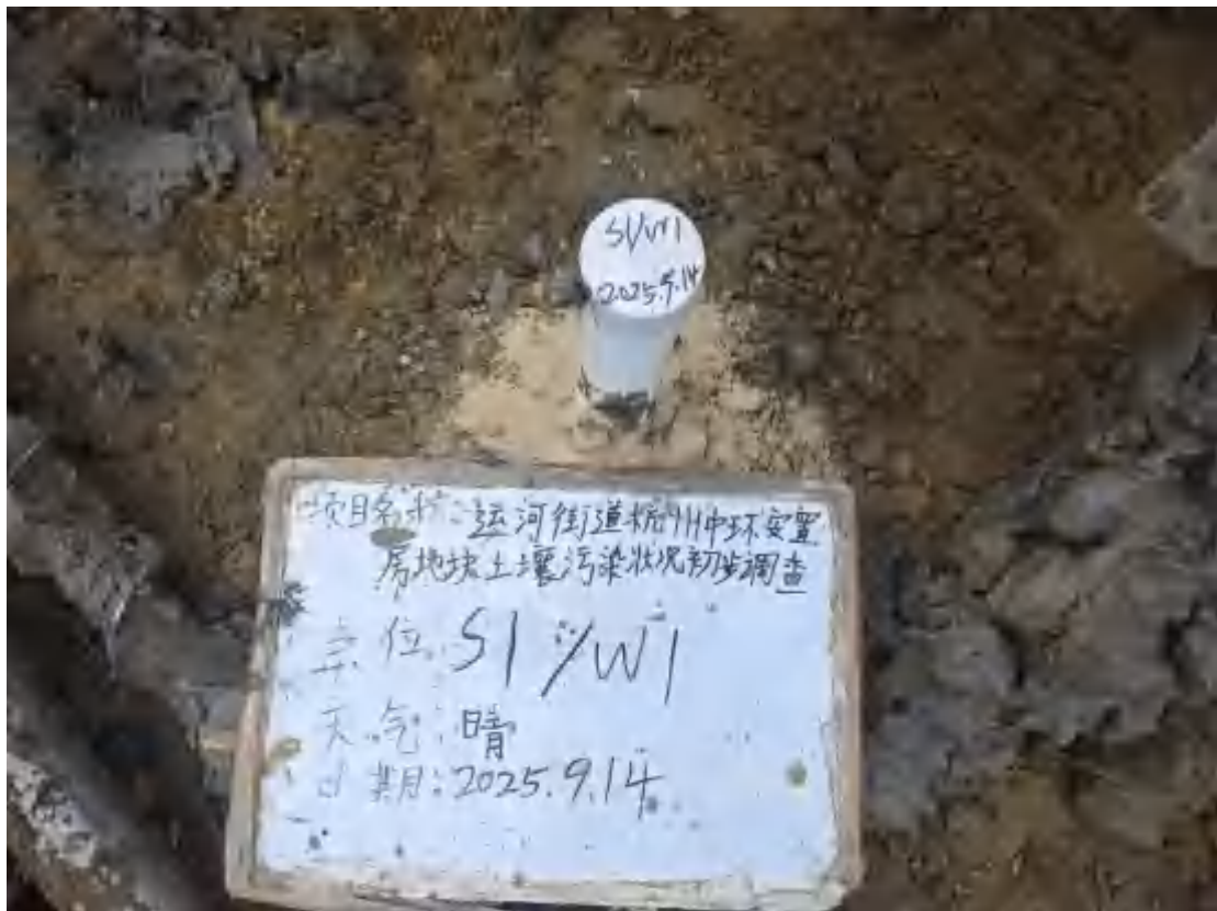
图 5-2 现场成井照片
